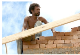
Construction de la crèche-bibliothèque, décembre 2009 A gauche Mr Rajaonary Dada, responsable de la ferme de Mahatsinjo. A gauche, Mr Rakotoniaina Herizo notre maçon.
