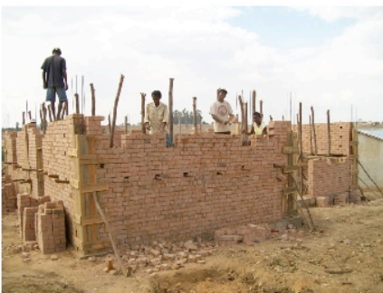
Construction de la crèche-bibliothèque, septembre 2009
