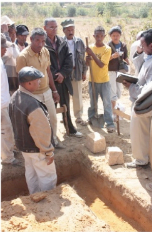
Pose de la première pierre
